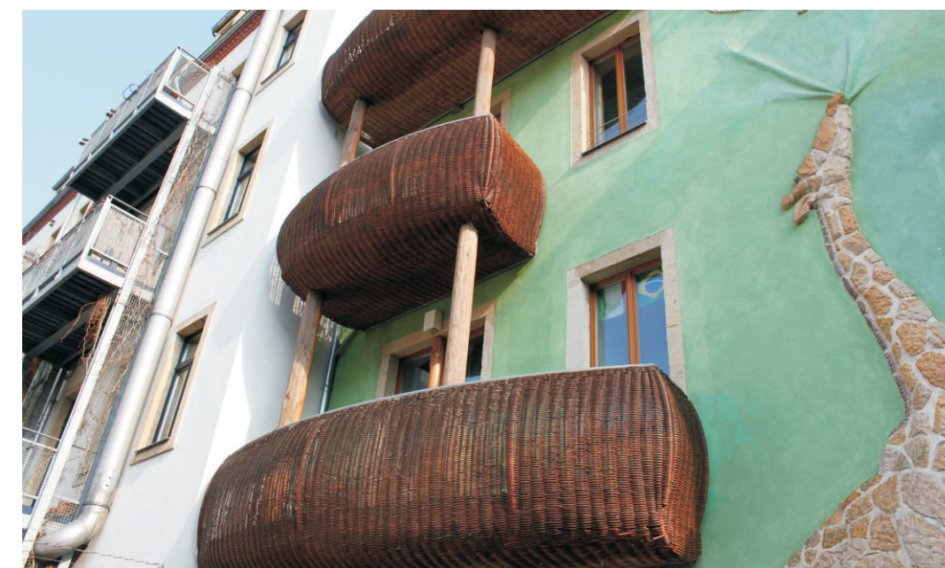
Grün gestaltete Fassade mit Weidengeflecht umspannten Balkonen im „Hof der Tiere“.
