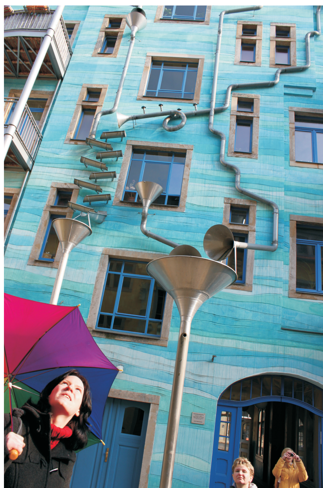
Blaue Fassade mit Regenrohren im „Hof der Elemente“ stellt das Element Wasser dar.
